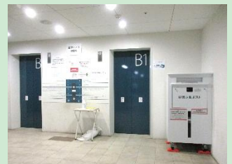
地下駐車場エレベーター前 ↑
